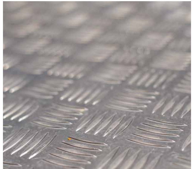
Boden mit Alu-Riffelblech belegt
